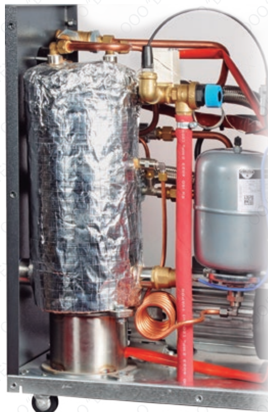
Внутренний вид водяного термостата Water units internal view
